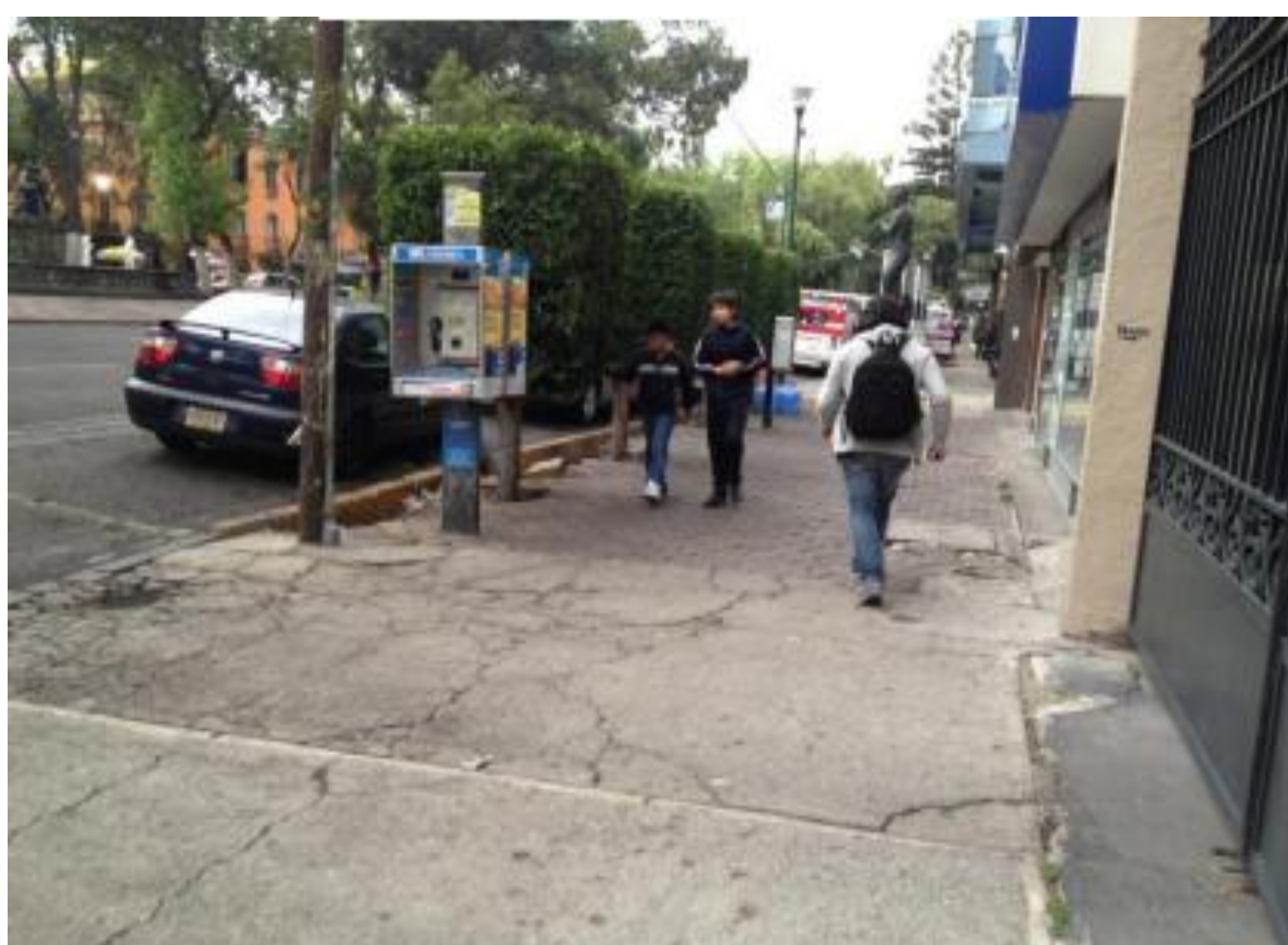
Banqueta fracturada
